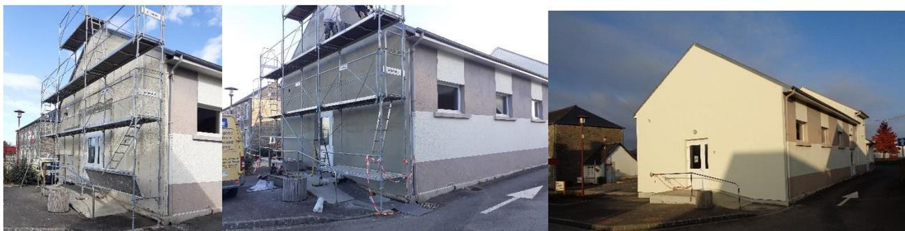
Rénovation du pignon ouest de la salle. L'habillage bois ayant pris l'humidité, il devenait urgent de le démonter. Une isolation par l'extérieur avec application d'un enduit assure désormais l'étanchéité.
